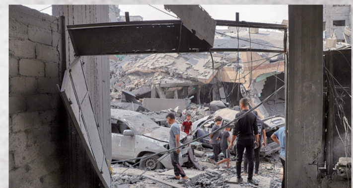
人们查看被以色列空袭炸毁的建筑废墟
