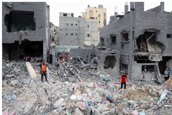
在加沙地带南部城市汗尤尼斯的建筑废墟
