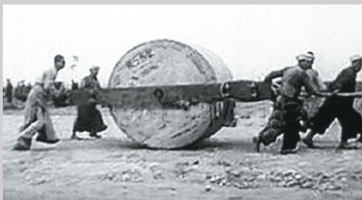
民工们拉着直径两米多的大石碾夯筑机场
