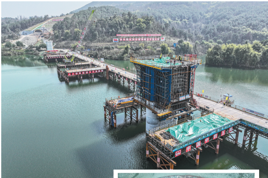
▲19日,在位于铜梁区的成渝中线高铁玄天湖大桥建设现场,工作人员在施工作业(无人机照片)。 新华社发
