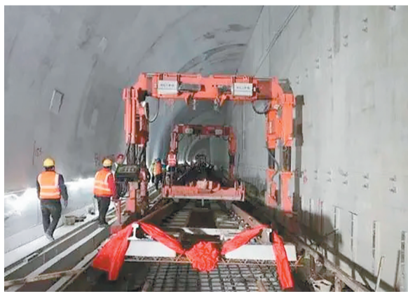
璧铜线建设现场 市住房城乡建委供图
