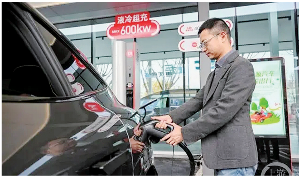
重庆首座智能超充示范站内的液冷超充终端
