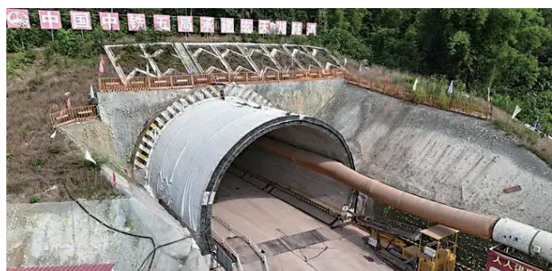
成渝中线玄天湖隧道贯通 铁路部门供图
