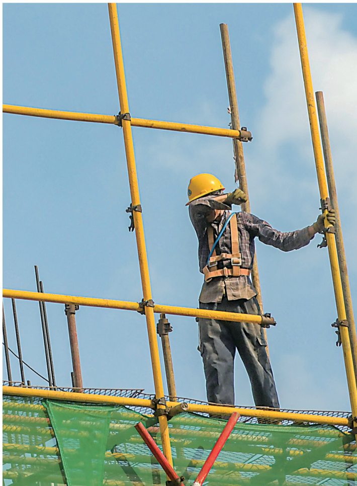
江北区耀星路,搭脚手架的建筑工人正在擦汗。
