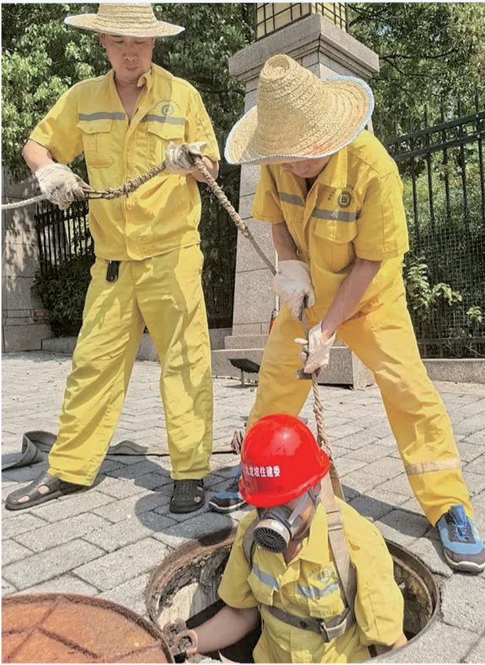
刘华忠到窰井盖下巡查管网 九龙坡区管线综合事务中心供图
