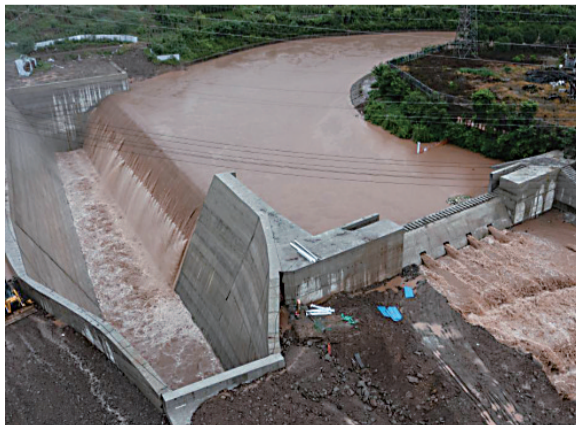
万州区五桥河流域工程 重庆市应急管理局供图
