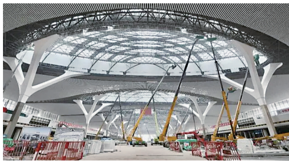
重庆东车站进入室内装饰装修
