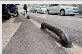
渝北龙华大道旁一支路上的隔离桩
