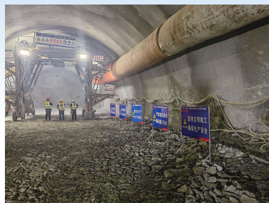
建设中的万达开高速公路
