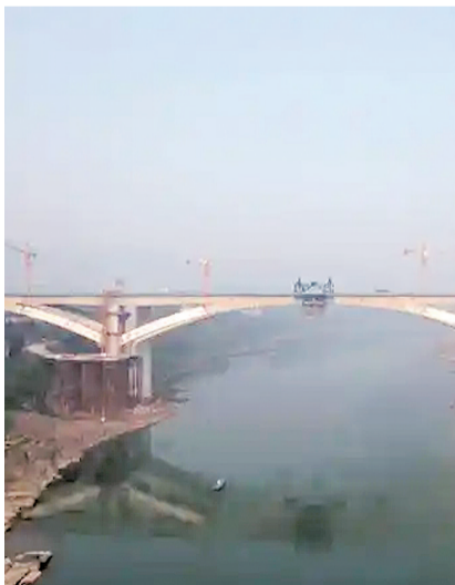
轨道交通15号线二期建设现场 市住房城乡建委供图
