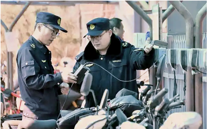
安全生产检查人员进社区对电动自行车充电区域进行用电安全排查
