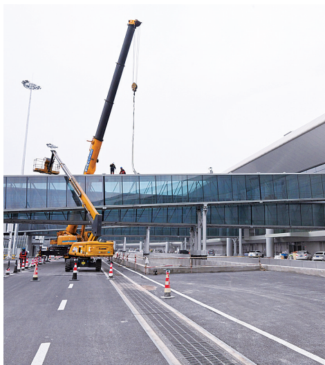
廊桥安装已全部结束
