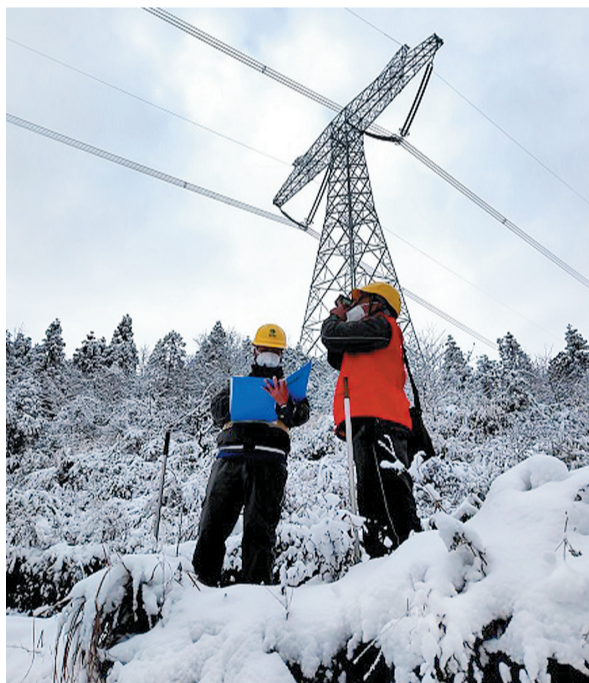
国网重庆电力员工对特高压输电线路覆冰情况进行观测和记录
