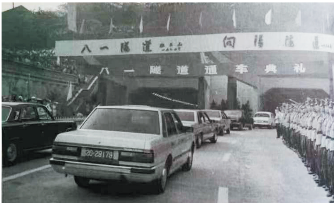
1986年8月1日,在驻渝某部官兵的努力下,八一隧道建成通车。
