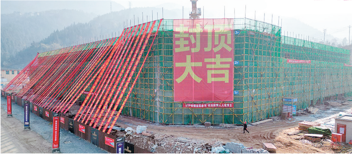
彭水扩城大幕正徐徐展开，图为建设中的靛水新城彭水汽摩家居商贸城。 黄杰 供图
