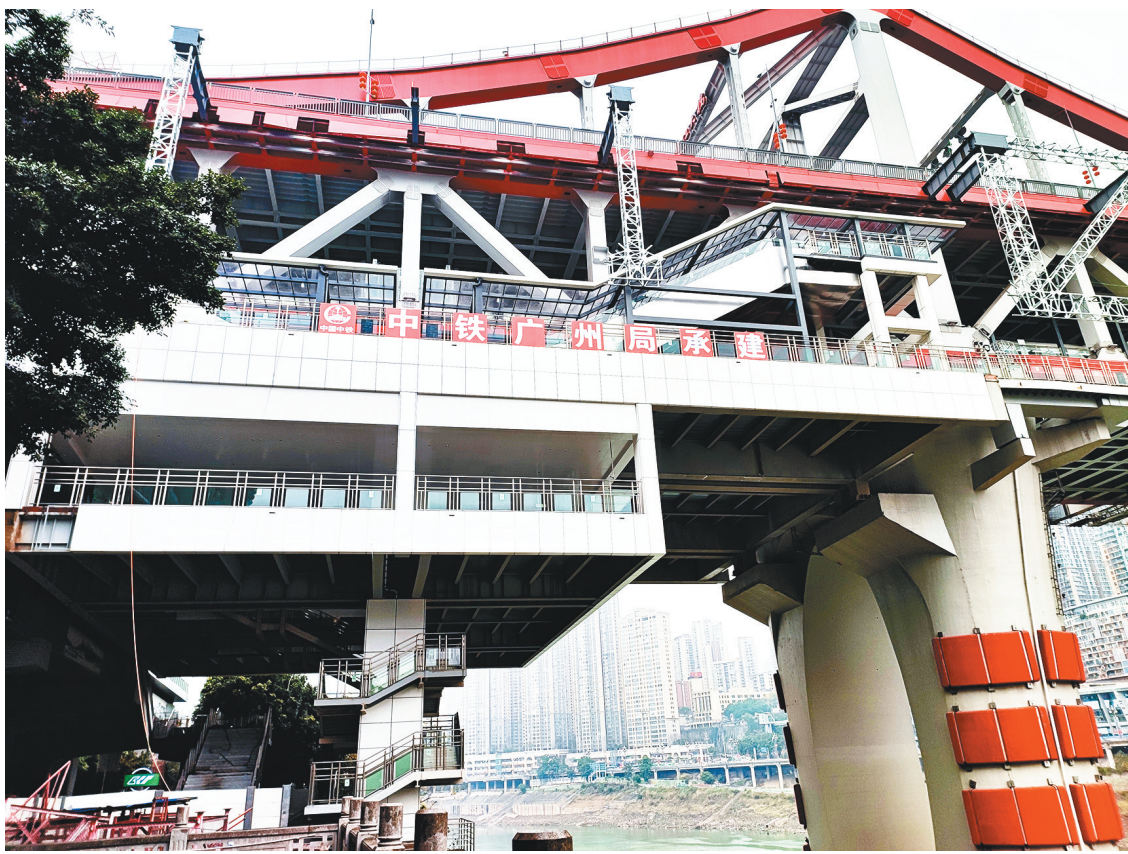
全國首個建在特大鋼桁梁橋上的軌道交通車站——曾家岩站
