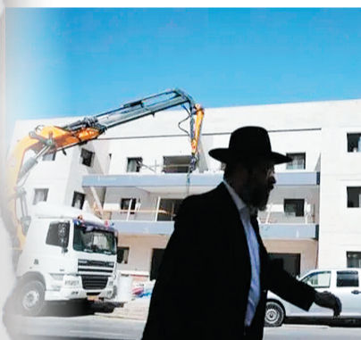
在东耶路撒冷的犹太人定居点拉马什格莫拍摄的房屋施工现场
