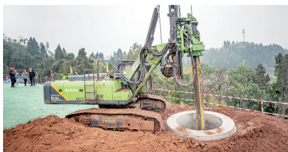
川渝特高压重庆段31号塔正运用旋挖机进行基坑开挖作业 (国网重庆电力供图)
