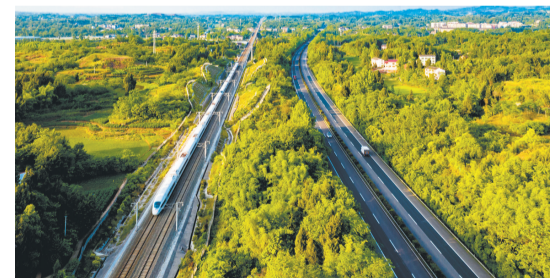
交通物流枢纽建设工程，高铁从沪蓉高速边驶过。
