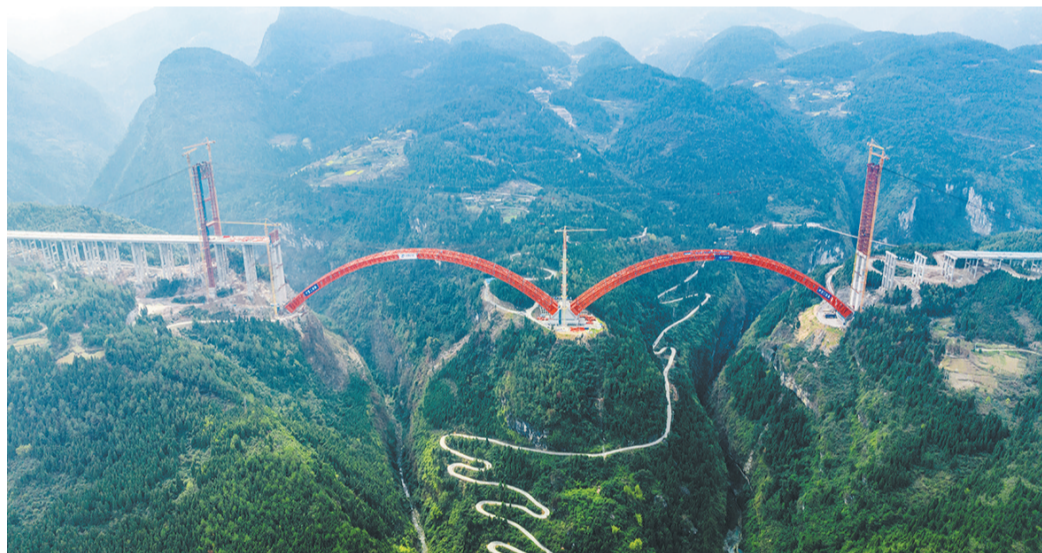
渝湘复线 高速公路双堡 特大桥梁合龙 重庆市交 通局供图
