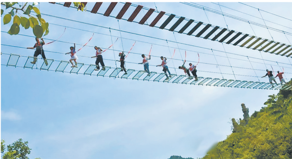
高空吊桥存在一定的安全风险
