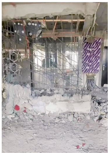
正在装修的室内，多面墙体被拆除，其中一面墙体钢筋缠绕。
