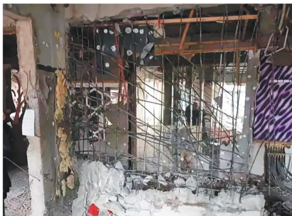
被拆掉的承重墙
