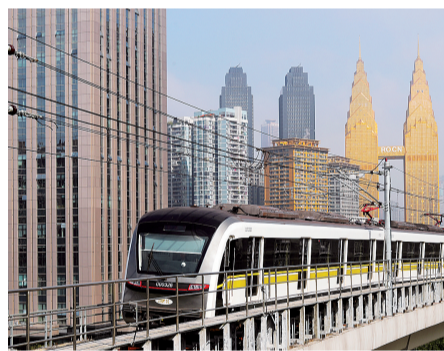
轨道交通海棠溪站
