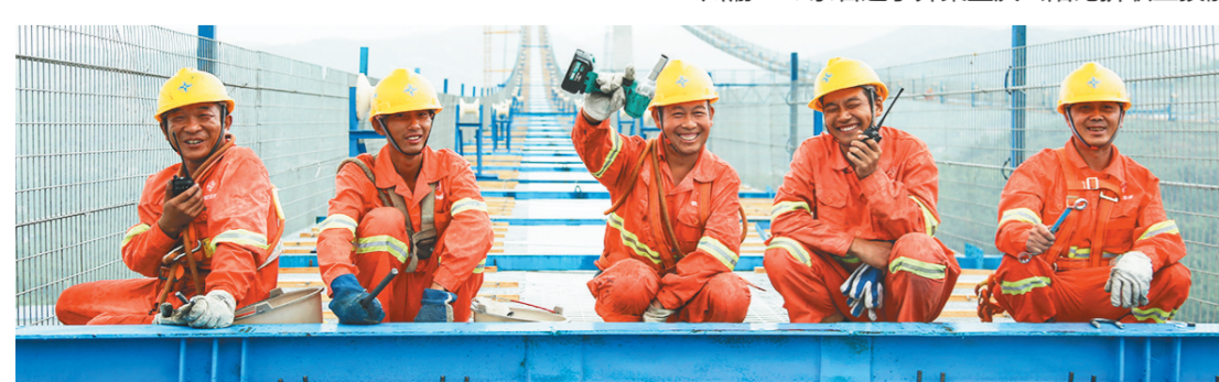
产业工人们架完千米猫道欢呼雀跃
