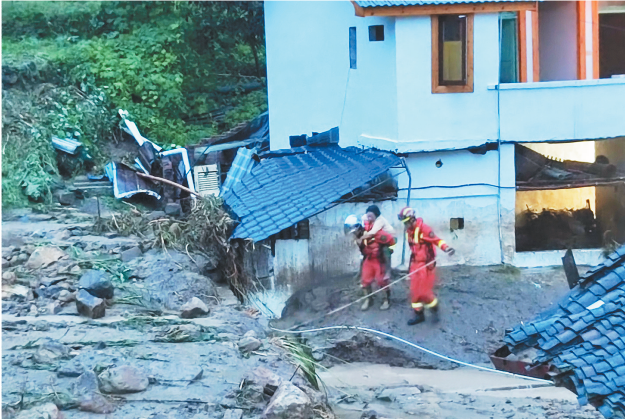
2日清晨,北碚区水土街道大地村,救援人员将群众安全转移、安置。 据重庆日报
