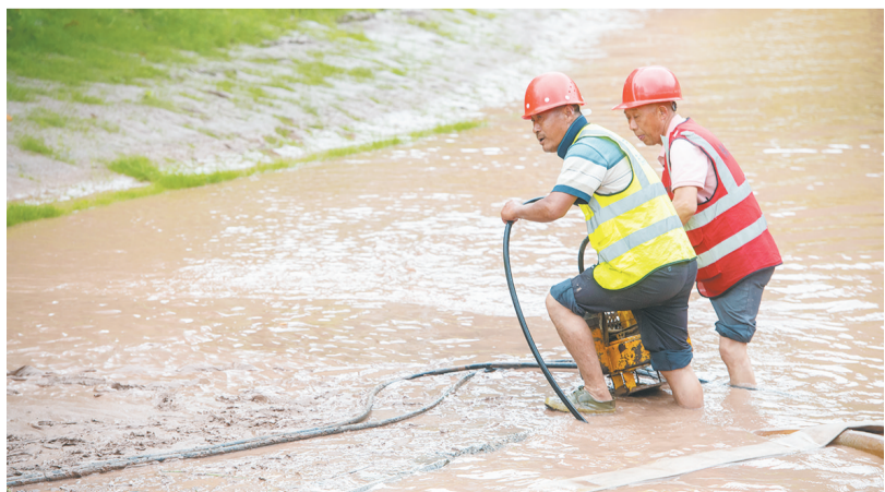
7月14日,在重庆市万州区江南新区,救援人员进行排水抢险作业。新华社发
