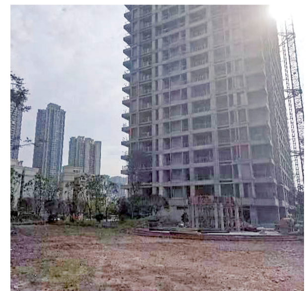
正在全力施工保交楼的恒大御龙天峰小区h02超高层住宅
