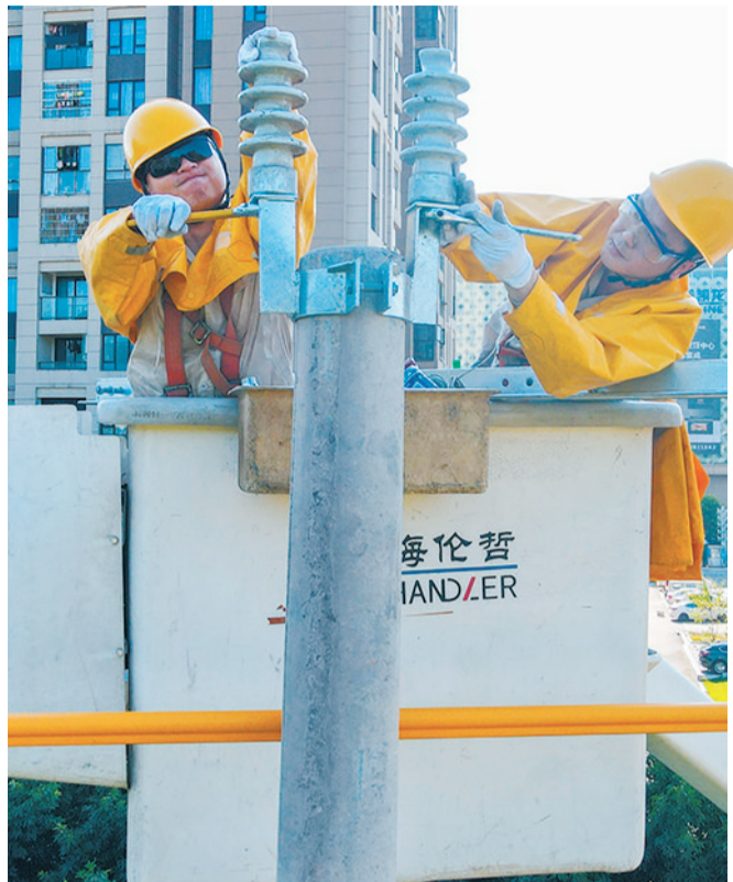
8月14日,国网重庆市南供电公司工作人员在近40摄氏度的高温下,进行带电立杆作业,服务重庆东站施工用电。
