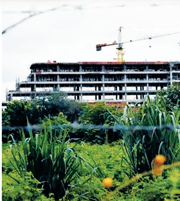
Dongfeng 园区中正在新建的建筑
