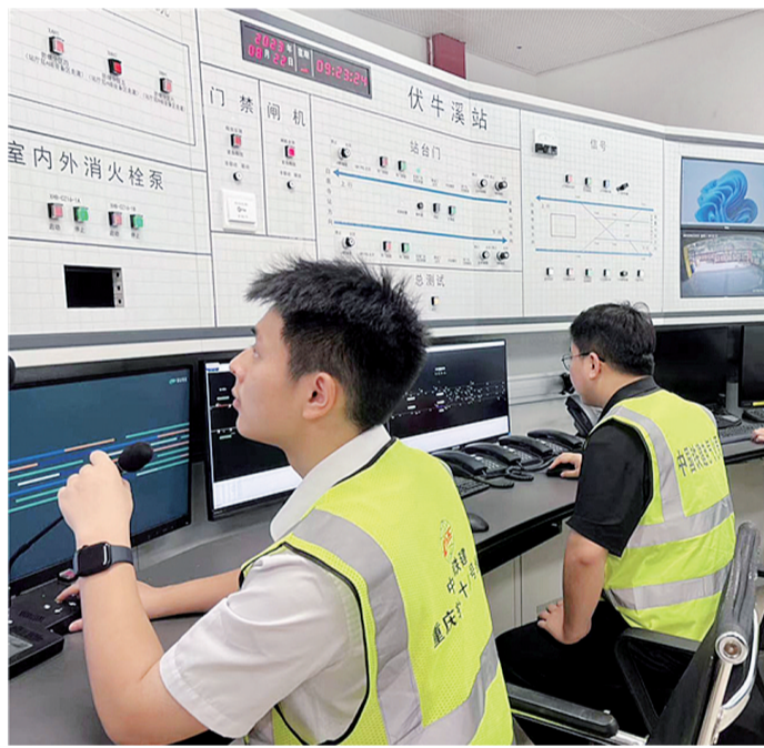
伏牛溪站，工作人员调试设备。
