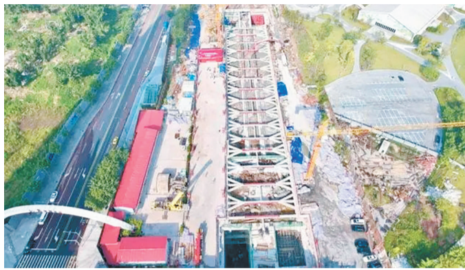
轨道交通15号线二期工程金山寺车站主体结构全面封顶
