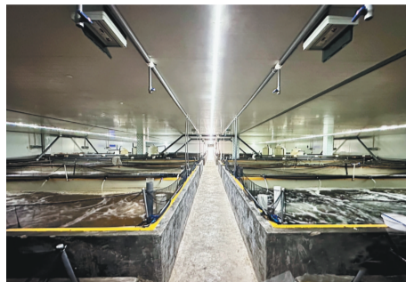
大足区大安农业园区的虾塘厂房
