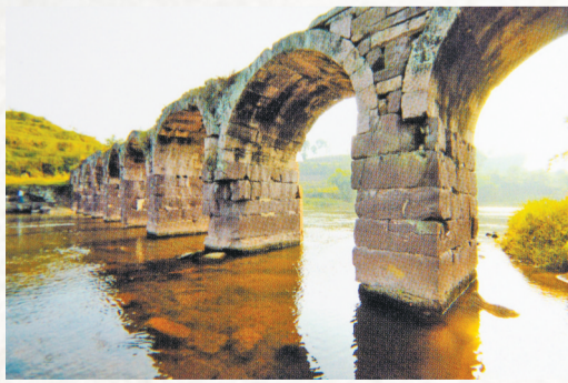
横跨笋溪河的大同龙门桥
