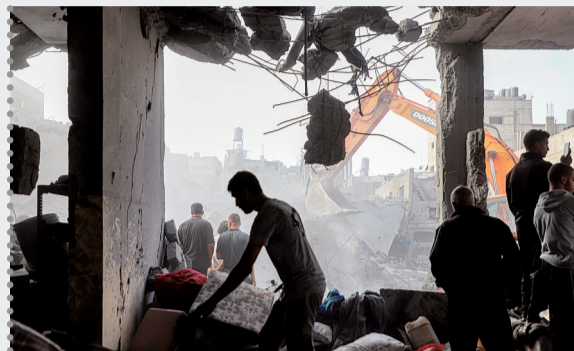
10月25日，在加沙地带南部城市汗尤尼斯，当地居民围观挖掘机在以色列空袭后的建筑废墟现场作业。
