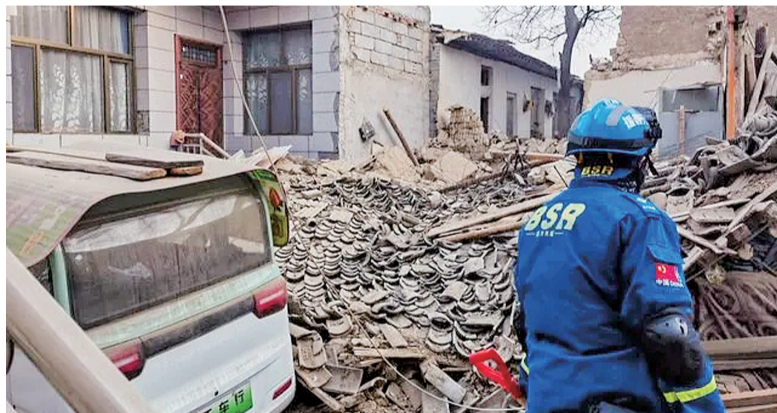
救援队员正在一处倒塌的房屋前探查情况
