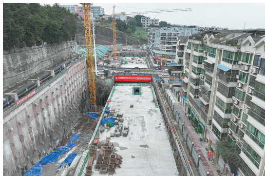
重庆轨道交通6号线东延工程长生老街站主体结构封顶。郭旭 摄
