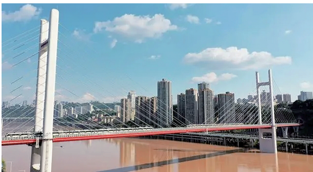
环线高家花园轨道大桥实景图 轨道集团供图
