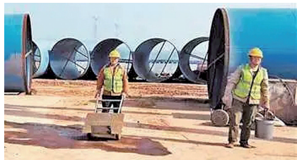
春节刚过，渝西水资源配置工程施工现场。（市水利局供图）
