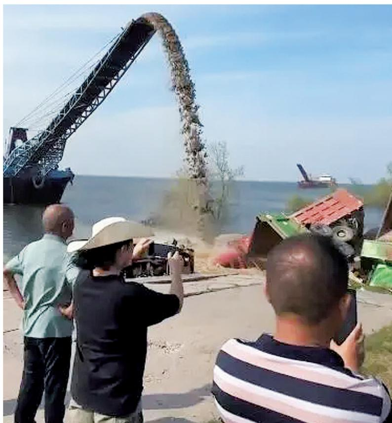
湖南省岳阳市华容县团洲垸洞庭湖一线堤防发生管涌险情,封堵失败后堤坝决堤,决堤口宽10米。滚滚洞庭湖水涌向团洲垸。短短一个多小时,决堤口宽度就从10米扩大至近100米。目前现场封堵抢险救援工作还在紧张进行中。
