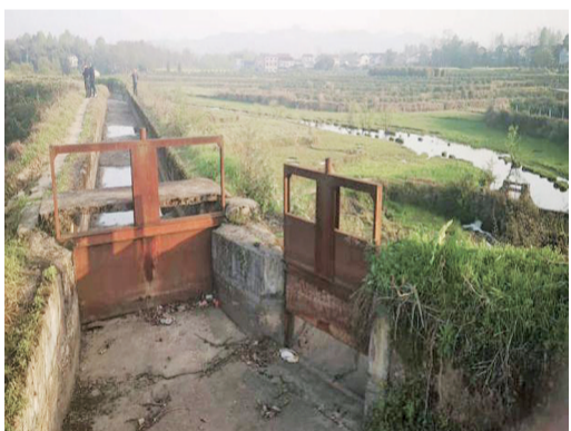
巨丰堰分水闸
