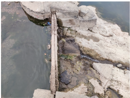
巨丰堰叠梁排沙闸
