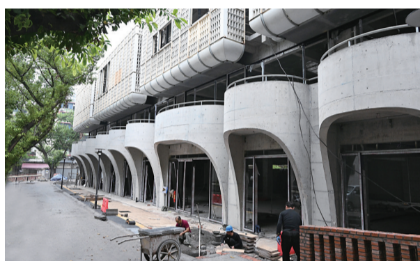
正在改建的民主村二期农贸市场
