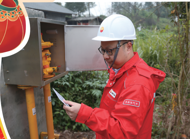
安超正在检查燃气管道各项指标
