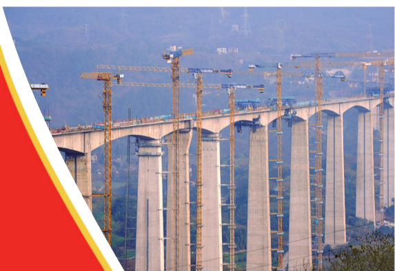
高架特大桥全景
