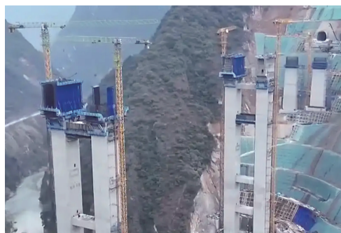
建设中的洛泽河特大桥
