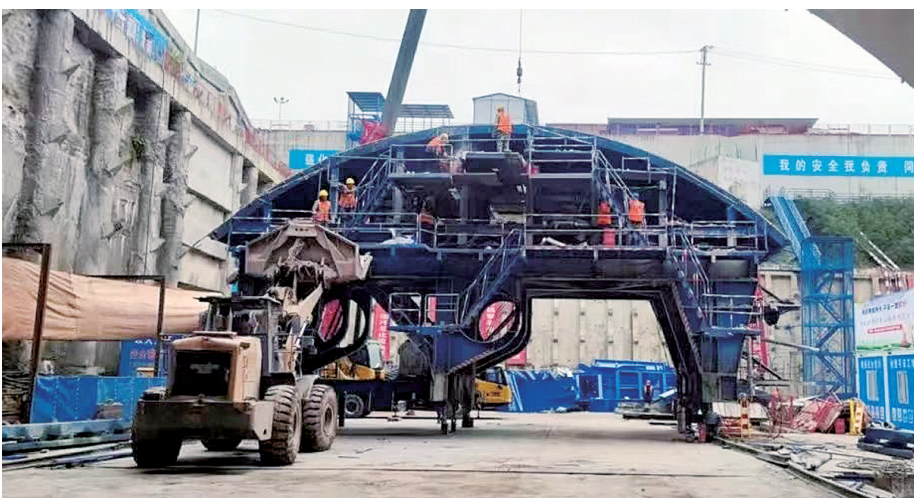
白市驿隧道建设现场
