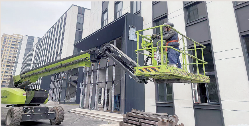
重庆佳凯创滨江创智云谷产业园内,施工人员正在安装大门。
